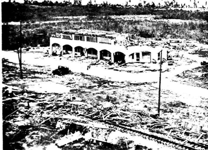
Un hotel de tres pisos arrasado por el ciclón. En último término se ve el vapor danés "Laise Maersk", arrojado por el viento sobre los arrecifes coralinos de Carysforth.
